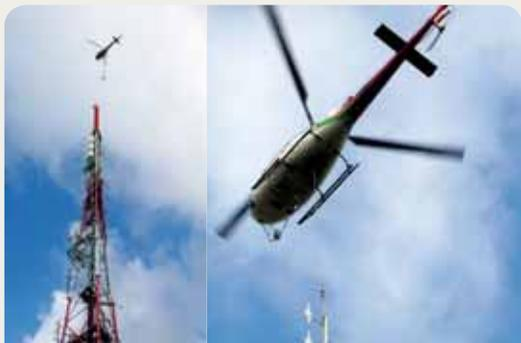
Mise en place d'antennes, par hélicoptère, au sommet du pylône de TDF (hauteur 100 m) au Guizay à St-Etienne, pour améliorer la diffusion des programmes de Radio Espérance dans la Loire.
